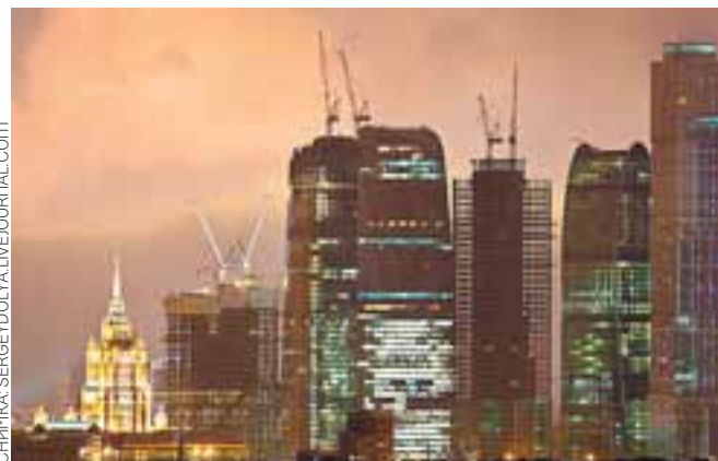
В "Москва-сити" етажите се заселват в хода на строителството
